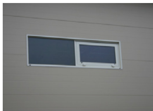
► Savunpoistoikkuna hallirakennuksen seinässä.
